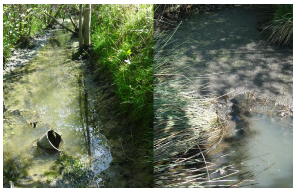
Figure 58 : Accumulation de boues et déchets sur la ZRV de Wahlbach-Zaessingue - AERM
