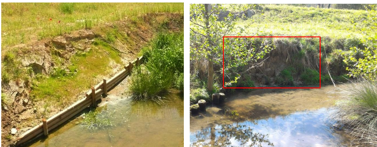
Figure 17 : Erosion localisée de la berge - AERM
