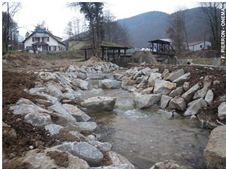
Le débit dans la passe est régulé par une vanne. Le niveau d'eau sera rehaussé jusqu'à la crête des enrochements afin d'augmenter la profondeur des bassins et favoriser l'attrait du dispositif (Janvier 2011).
