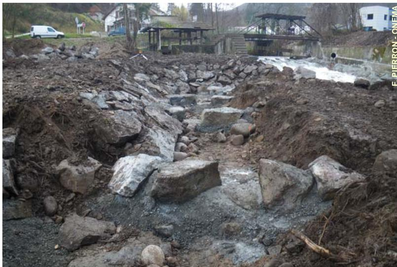
Les seuils sont composés d'enrochements bétonnés afin d'assurer leur stabilité. Les rives ont également fait l'objet d'enrochements (Novembre 2010).
