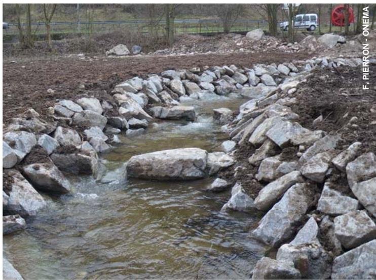
Avec de faibles chutes, la rivière de contournement offre des conditions de franchissement confortables pour l'ensemble des espèces. (Janvier 2011).
