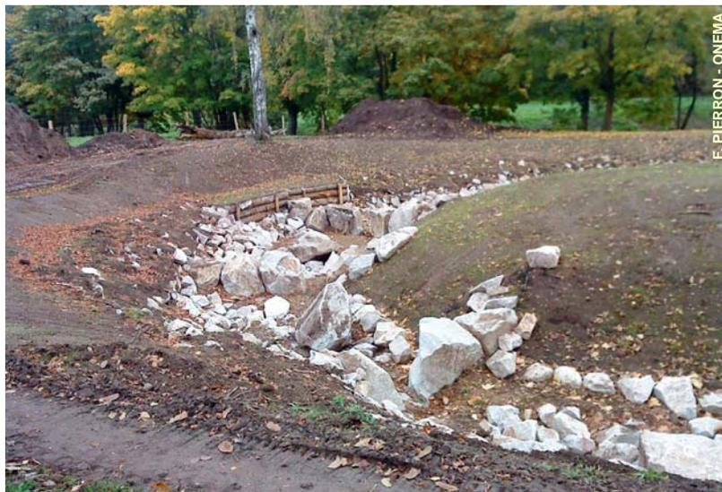
Le fond de la passe présente une pente homogène. Des blocs sont positionnés au fond du lit pour créer de la rugosité et favoriser la remontée des petites espèces (Octobre 2010).
