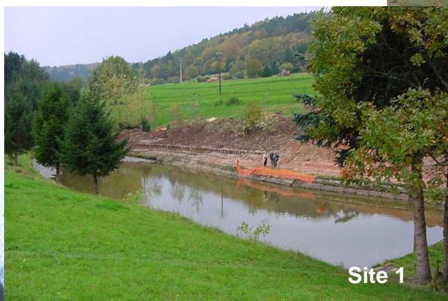
dérivation après les travaux
