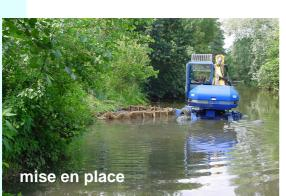
En 1999, les travaux ont consisté à créer dans le lit actuel un sous-lit mineur et à le stabiliser par l'implantation de 8 épis triangulaires en pieux de bois. Ces épis sont orientés vers le milieu du lit de part et d'autre du cours d'eau. Ces ouvrages ont été complétés par des boudins d'hélophytes.
