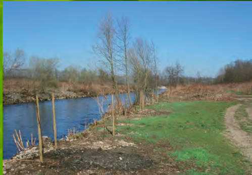
Mise en œuvre de plantations surdensitaires sur des massifs de renouées après fauche et exportation des cannes
