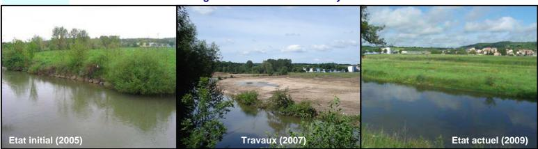
Grâce aux décaissements du lit majeur, à la création de chenaux de crues et au reprofilage des berges, les échanges hydrauliques et écologiques entre le cours d'eau et sa plaine d'inondation sont redynamisés. Cette nouvelle configuration en « lits emboîtés » permet notamment d'améliorer les conditions d'écoulement en période de crue et ainsi de diminuer de 10 à 20 cm la hauteur d'eau dans Lunéville pour des crues moyennes à fortes.
