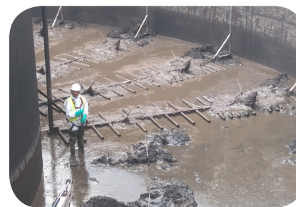
Bassin d'aération avant et après vidange et remplacement des diffuseurs.
