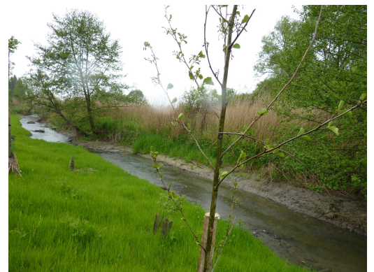
A gauche, protection de la banquette par un géotextile biodégradable, ensemencement et plantation d'arbres, et le rendu, à droite, 6 mois après travaux
