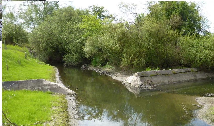
Avant et 6 mois après travaux : le lit du Mutterbach est moins profond et plus étroit
