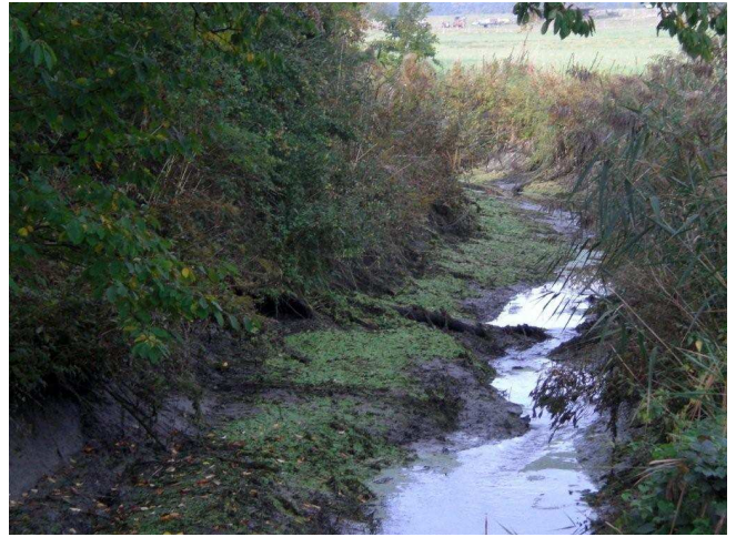
Recréation naturelle d'un lit mineur d'étiage sur le Mutterbach entre deux seuils échancrés juste après travaux
