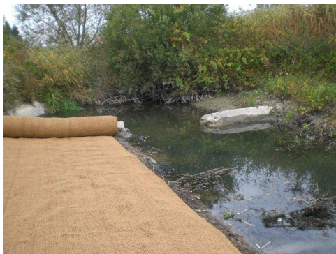
A gauche, protection de la banquette par un géotextile biodégradable, ensemencement et plantation d'arbres, et le rendu, à droite, 6 mois après travaux
