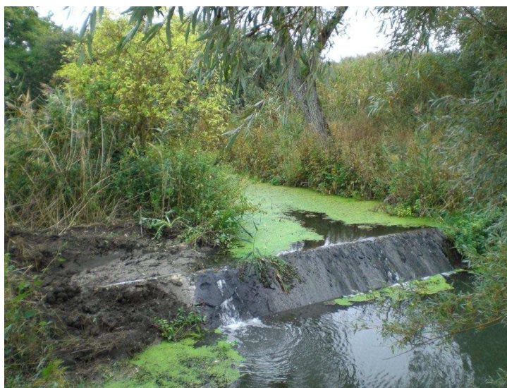
Effet « plan d'eau » avec un fort développement de la végétation en amont du seuil
