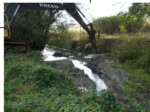
Travaux en cours sur le Mutterbach
