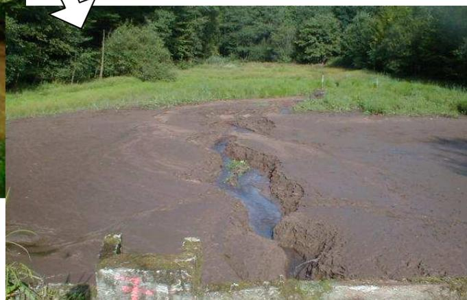
**2. Effacement des six digues d'étangs**, d'amont en aval. Le cours d'eau est dérivé au niveau de l'ouvrage pour maintenir une continuité hydraulique, les ouvrages de vidange sont supprimés et la digue ouverte avec un reprofilage en pente douce. Les travaux ont été effectués septembre 2008.
