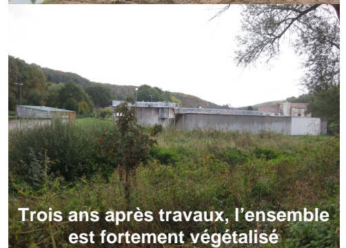
Après travaux, un cours plus naturel
