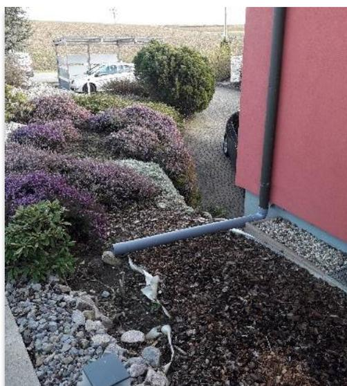
Déconnexion avec présence d'un sous-sol. Eloignement de la zone d'infiltration pour limiter les risques d'infiltration le long du mur. Surface déconnectée d'environ 40 à 50 m<sup>2</sup>. Végétation et infiltration de surface permettent d'évacuer une majorité de l'eau par évapotranspiration
