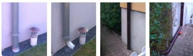
Pour déconnecter une gouttière, il s'agit concrètement de la scier, d'installer un coude et de poser un bouchon sur la sortie existante. Différentes solutions sont possibles : soit un coude normal (à gauche, avant / après), soit un tuyau plus long pour arriver jusqu'à un espace naturel (à droite). DOCUMENTS REMIS
