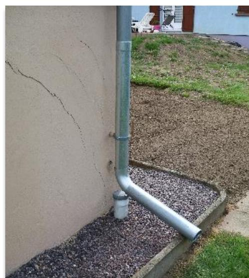
Déconnexion avec pourtour de gravier. Rallonge nécessaire pour infiltration des eaux dans le gazon. Absence de sous-sol
