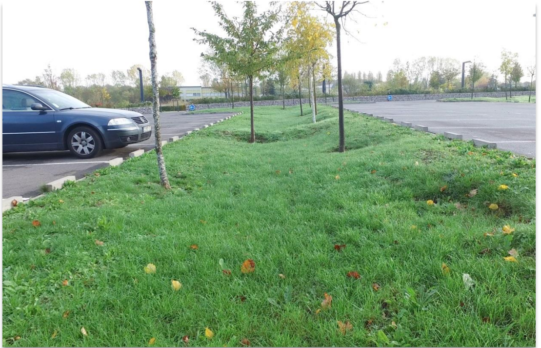
Noue d'infiltration entre les zones de stationnement et parking en structure réservoir - îlot central
