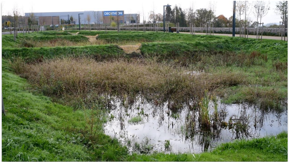
Bassins d'infiltration en escalier
