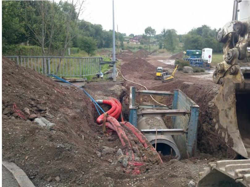
**Fig. 65.** Travaux de renforcement du réseau d'assainissement
