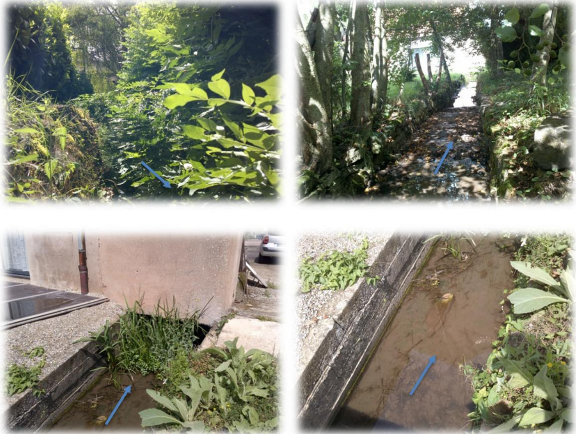
**Fig. 94. Fond du lit bétonné et colmaté- passage busé – photos d'amont en aval**
