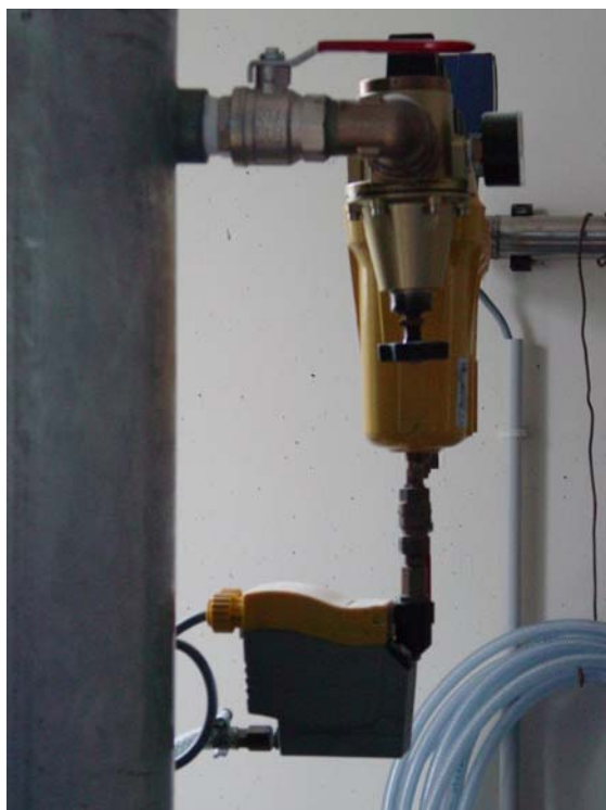
I5 : Filtres pour l'air de service
