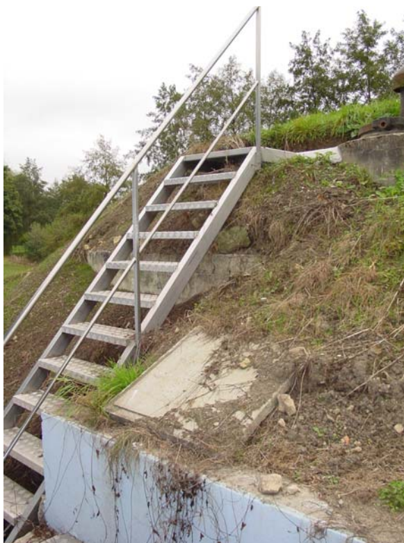
04 : Réservoir de la station avec escalier d'accès
