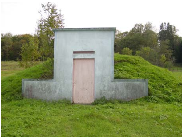
25 : Réservoir de la Vacheresse et la Rouille
