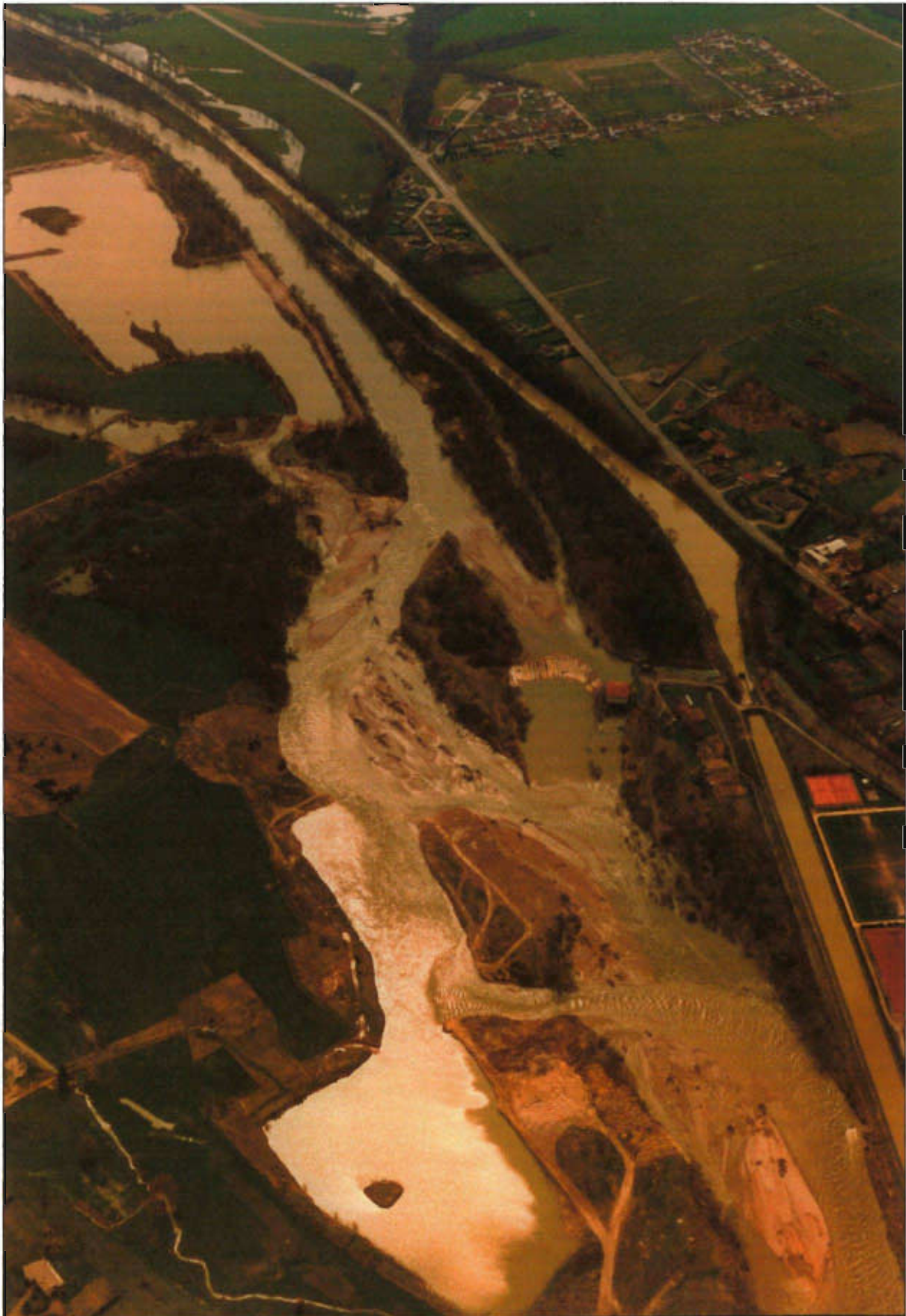
Figure 16 : Lors de la crue de 1983, la Moselle a modifié son cours au voisinage du barrage et des puits
