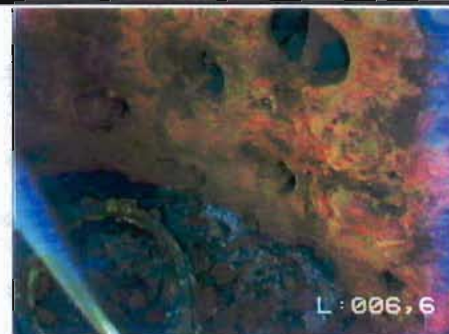
Puits Haillottes N°3 Fond du forage
