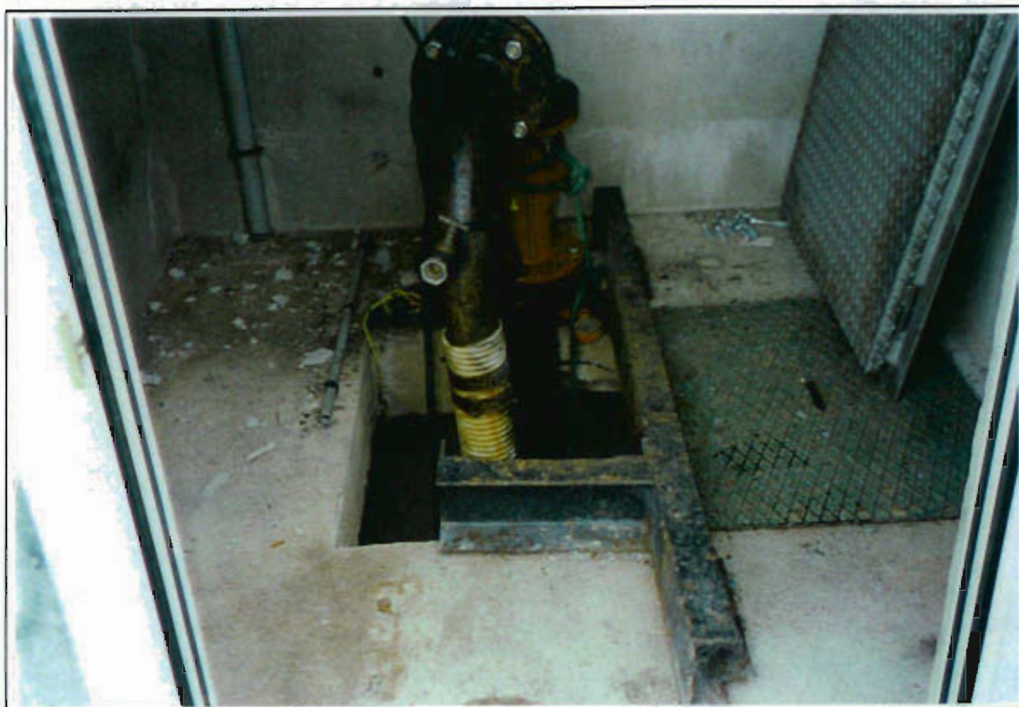
Cliché n° 22 : Vue au niveau du radier de la station du Puits des Haillottes 2
