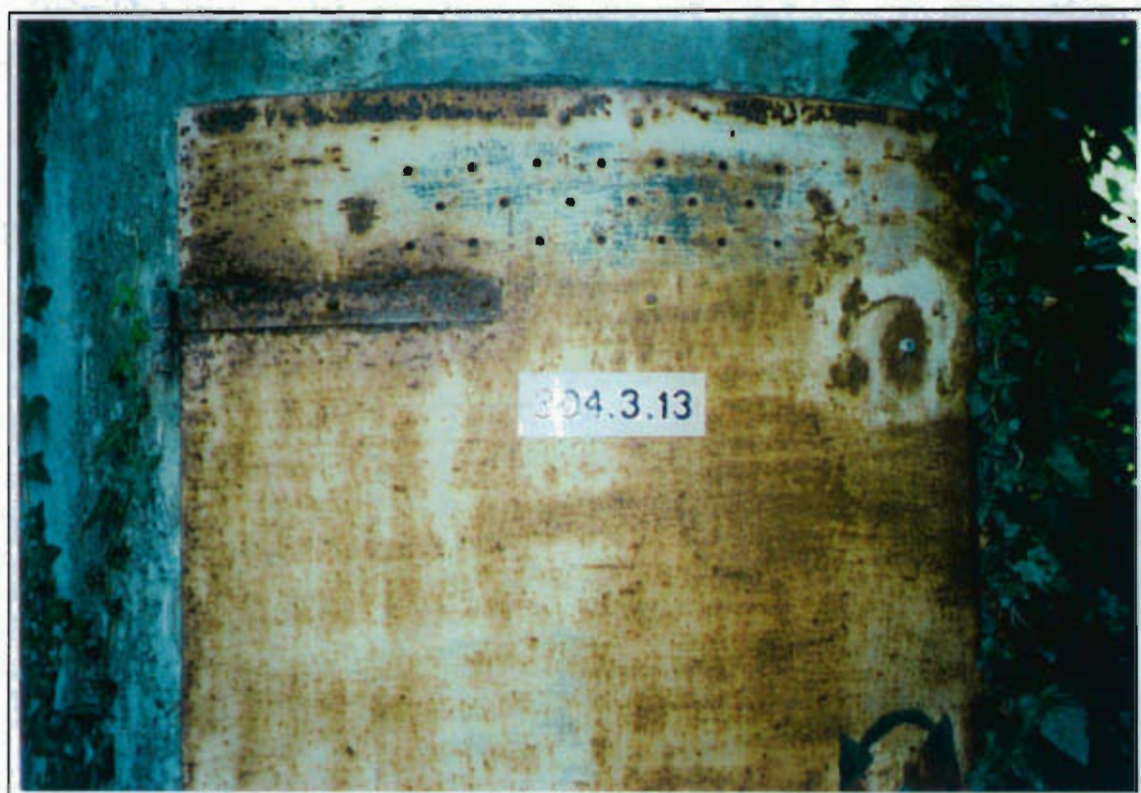
Cliché n° 34 : Le portail d'accès et le numéro d'identification
