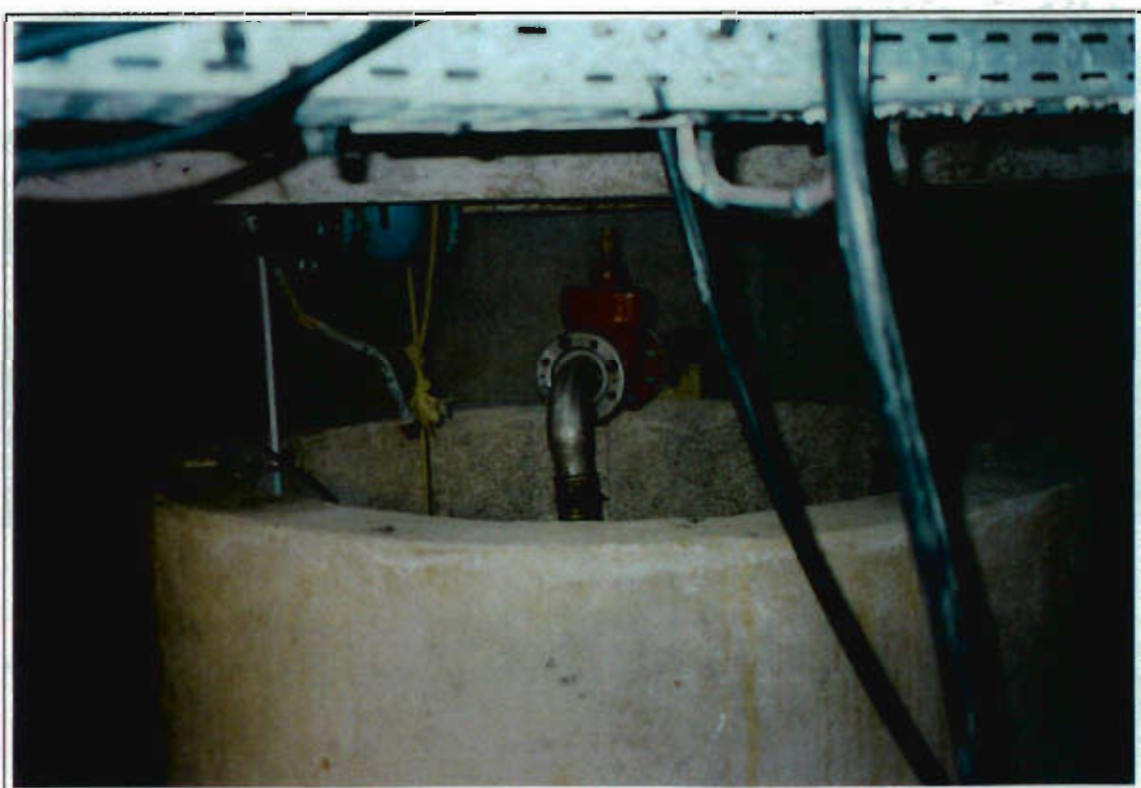
Cliché n° 15 : Vue du sommet de la superstructure du Puits des Iles 1
