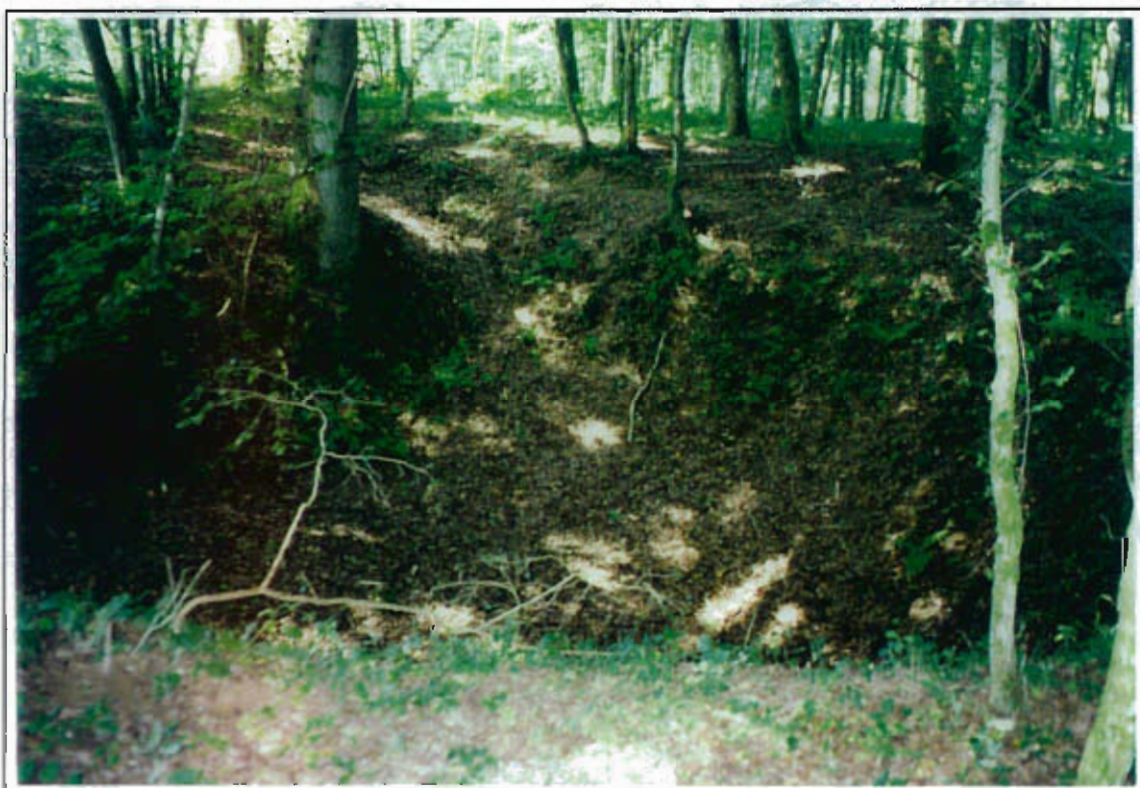
Cliché n° 32 : Effondrement lié à la dissolution des calcaires
