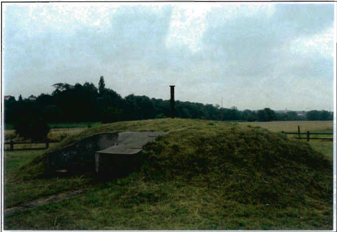
Cliché n° 3 : Vue extérieure de la bâche d'accumulation-reprise
