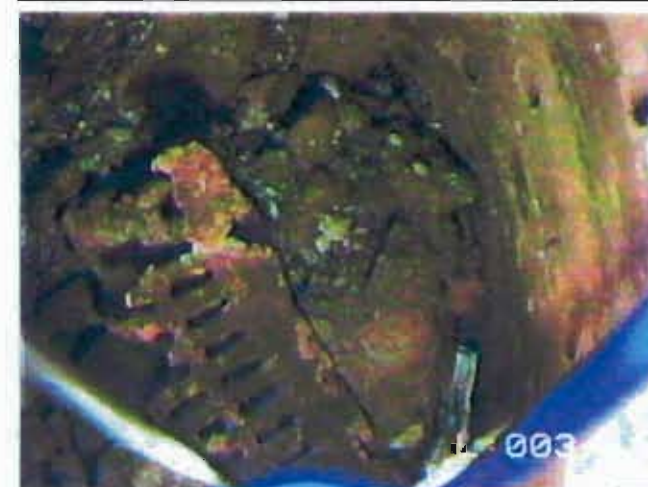
Puits Haillottes N°2 Fond du forage
