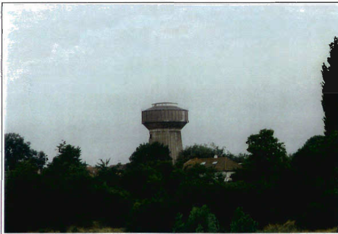
Cliché n° 6 : Vue extérieure du réservoir du Bout du Pont
