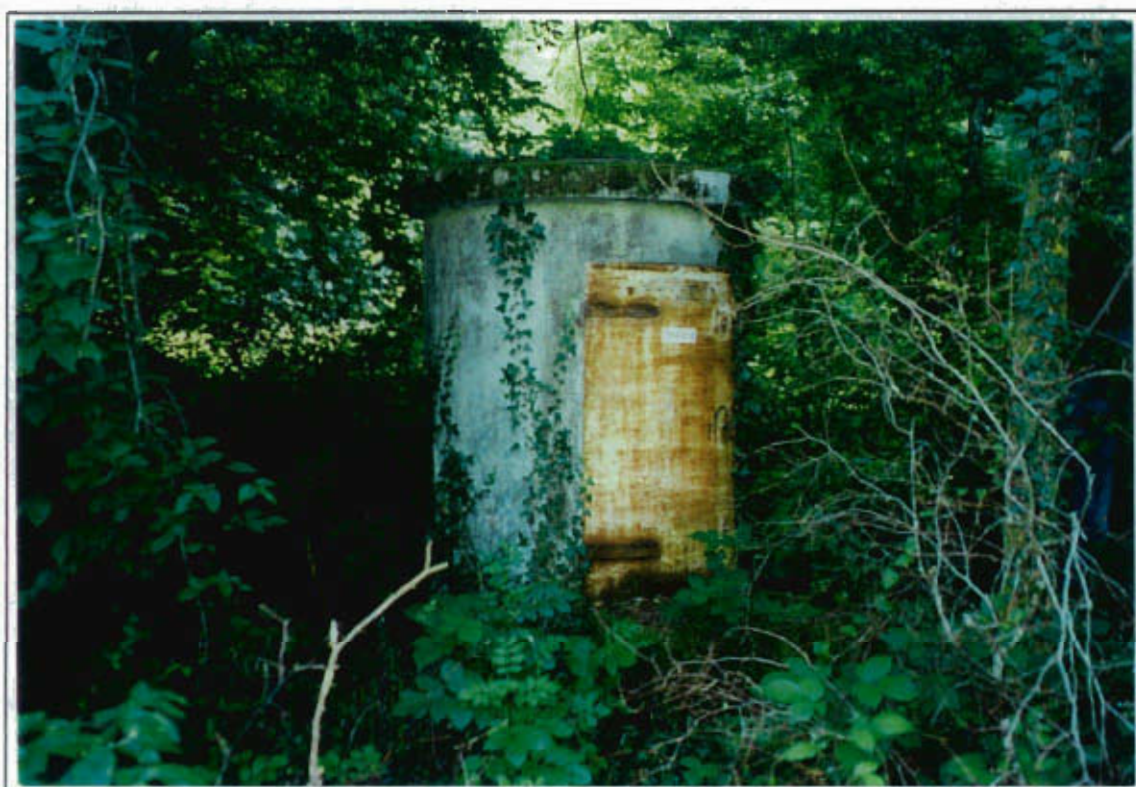
Cliché n° 33 : Regard de visite de la Fontaine Gauffy
