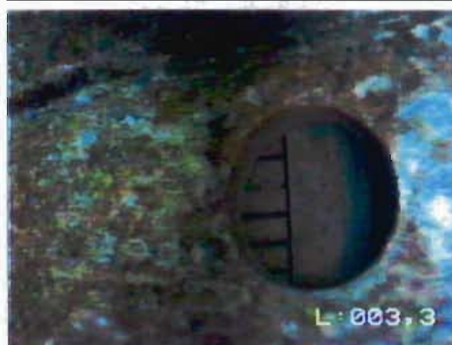
Puits Haillottes N°2 Crépine renforcée
