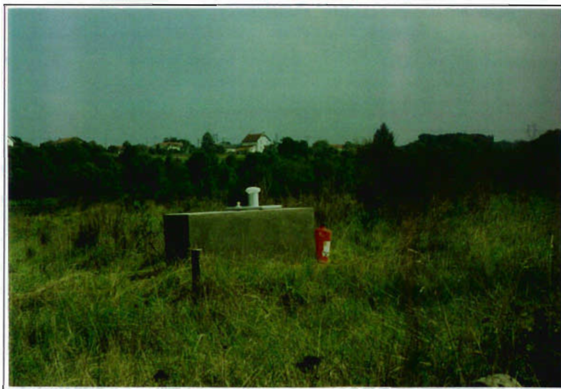
Cliché n° 24 : Superstructure apparente du Puits des Haillottes 3
