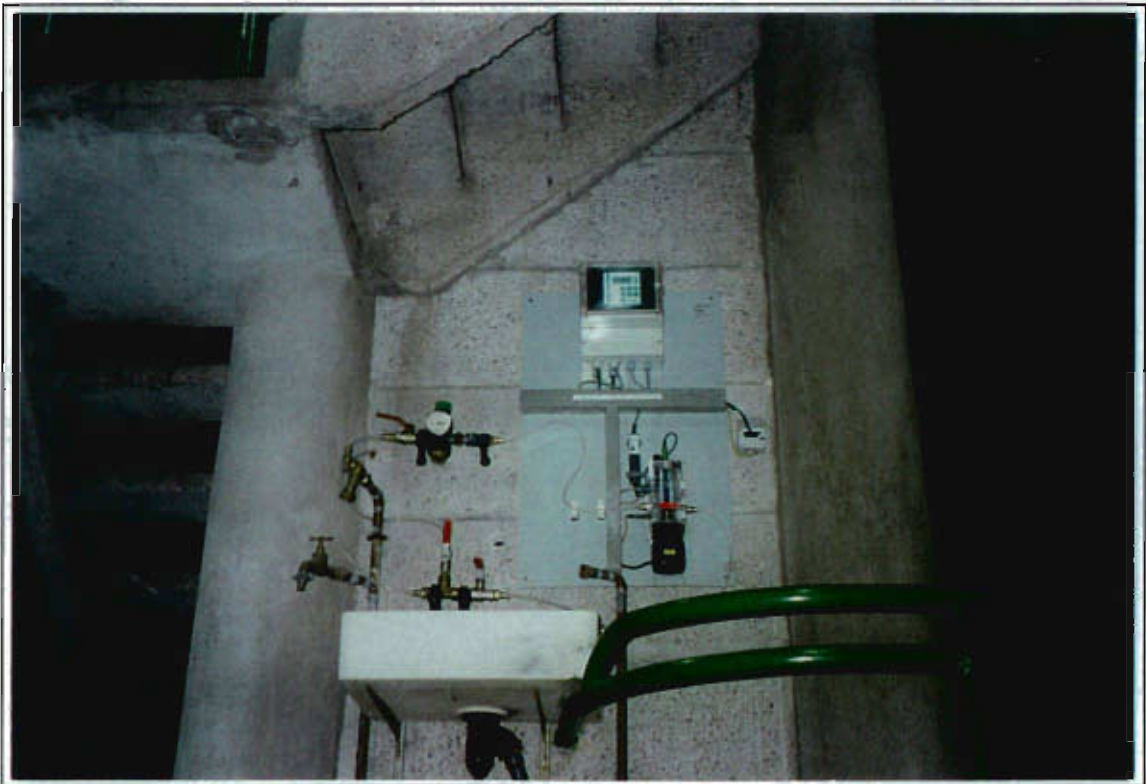
Cliché n° 5 : L'analyseur situé dans le réservoir
