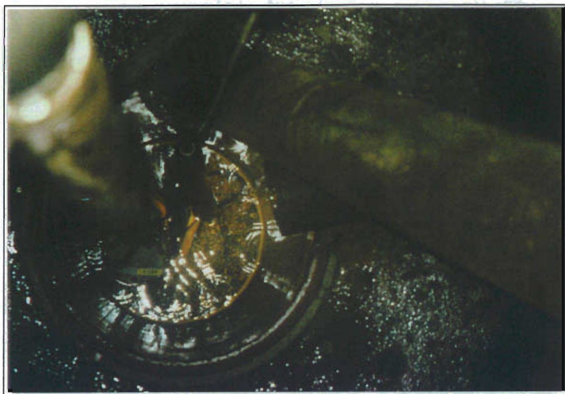
Cliché n° 30 : Pendant l'inspection dans le Puits des Iles
