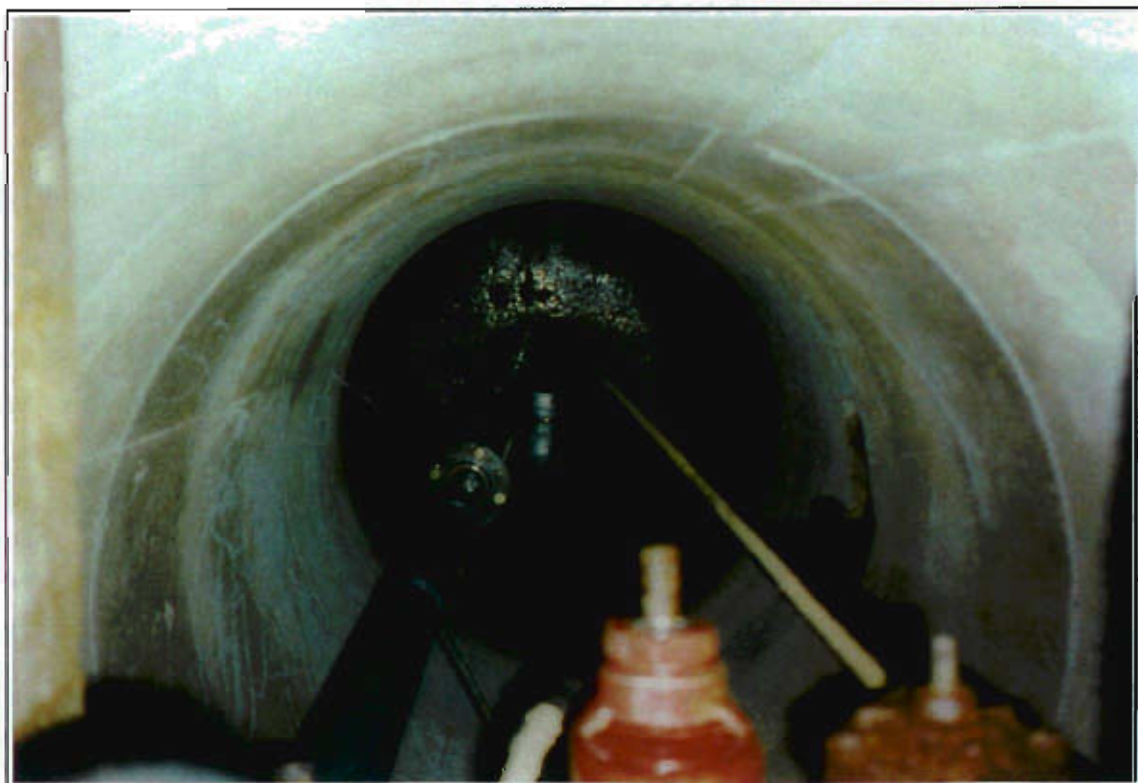
☛ Cliché n° 20 : Vue intérieure du Puits des HAILLOTES 1
