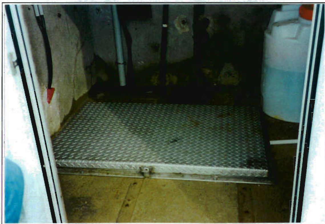
Cliché n° 18 : Plaque métallique de protection au dessus de la tête du Puits des Haillottes 1
