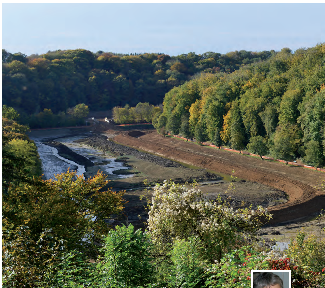
Des travaux titanesques pour un nouvel environnement.
