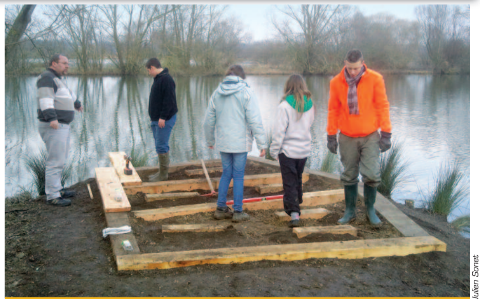
Travaux pratiques. Construction d'observatoires et réalisation d'un ponton pour pêcheur à mobilité réduite.
