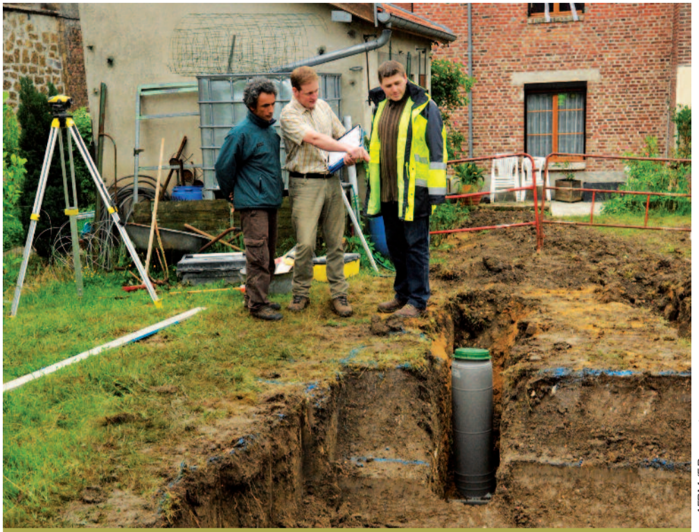
L'assainissement non collectif est une solution qui peut être intéressante pour les petites communes.
